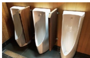
完成した男性用トイレ
