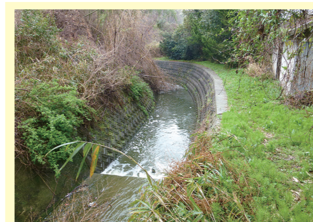
■市街化調整区域北側法面と平尾小川の状況(平成27年4月)
