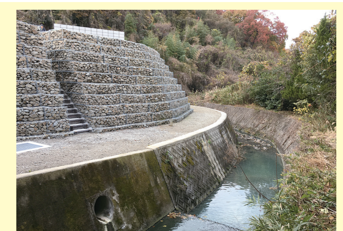
■市街化調整区域北側法面の安全対策工事完了後(平成28年12月)
