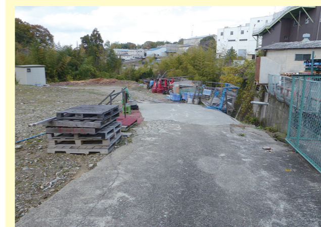
■擁壁工事着工前(平成26年12月)
