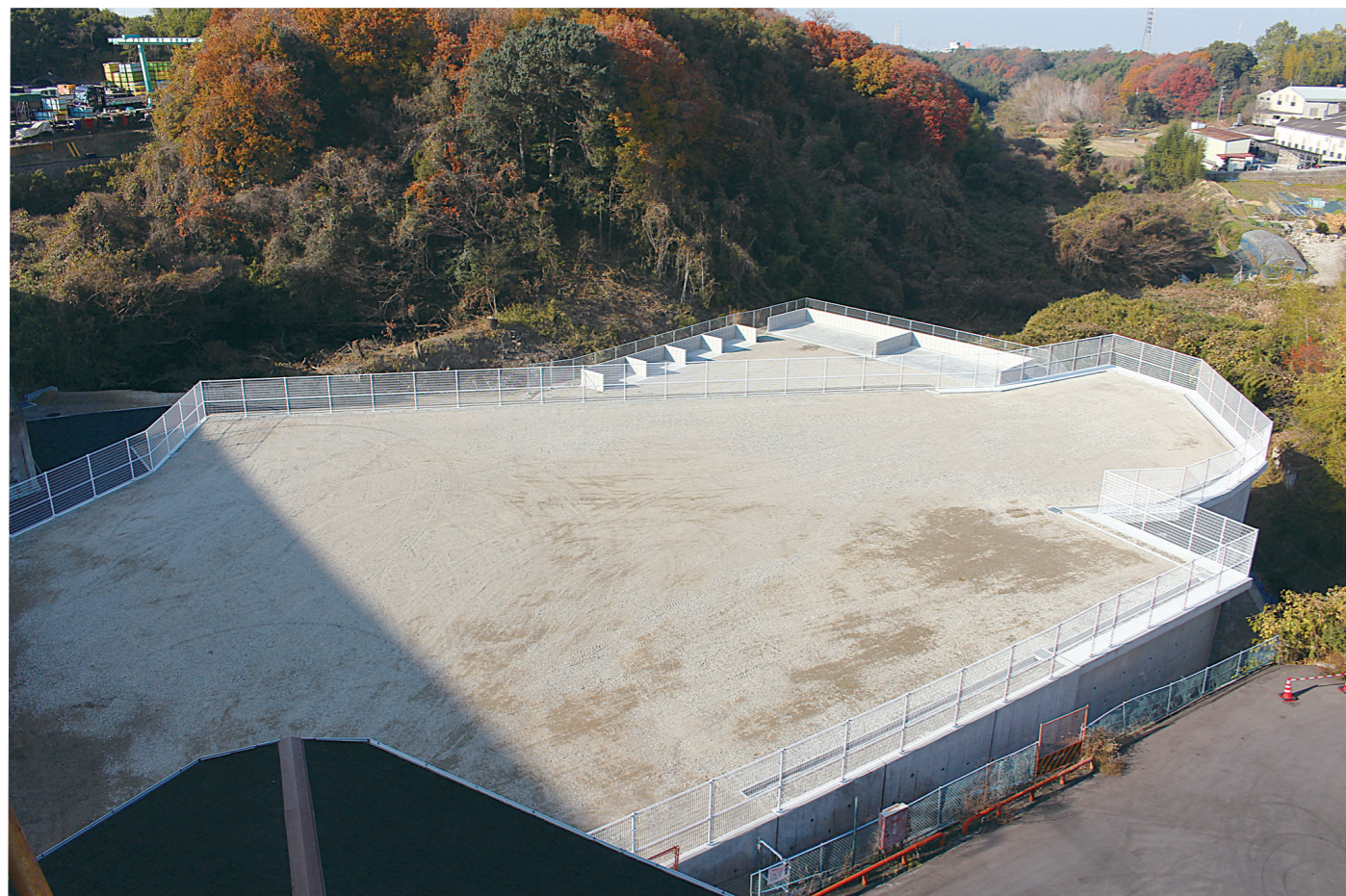
開発工事完了後の全景写真
